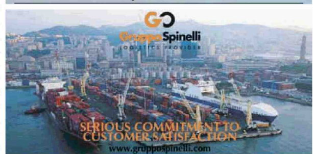
Il terminal portuale di Genova Prà
